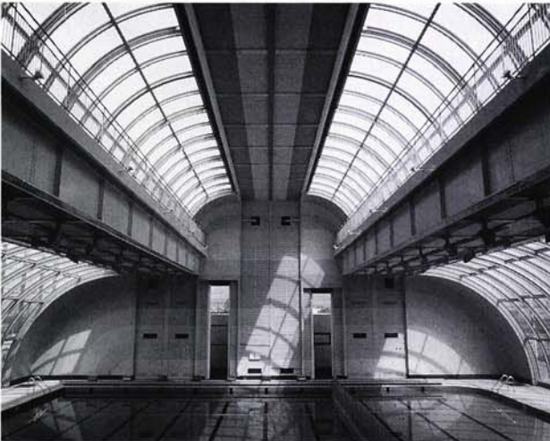
写真(5)-6B 屋内プールの屋根(PC)
