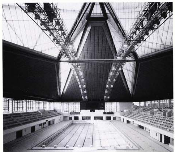
写真(5)－6A 屋内プールの屋根(PC)
