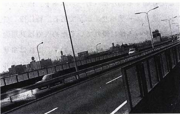
写真(5)－4 高速道路の遮音壁(PC)
